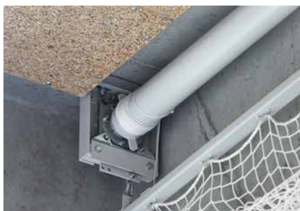
Arbre d'entraînement côté palier (sécurité de roulement)
