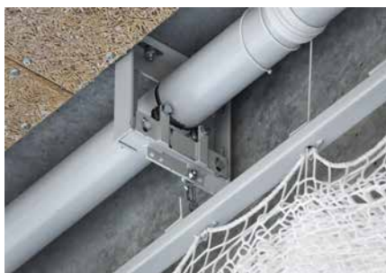
Arbre d'entraînement central et tige de maintien du filet avec fixation du filet
