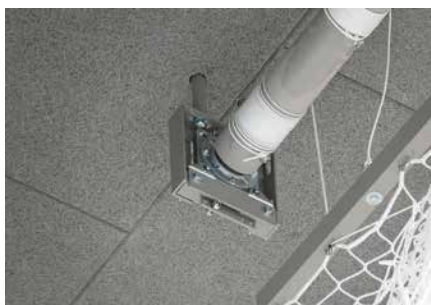
Antriebswelle lagerseitig (Abrollsicherung)
