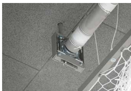
Arbre d'entraînement côté palier (sécurité de roulement)
